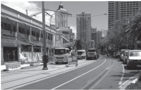
ゴールドコーストLRT建設現場
