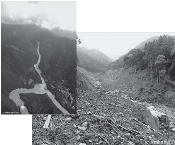
2011年7月撮影 高知県東部（平鍋地区）現地被災状況
