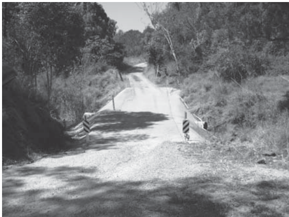
写真1 被災現場の様子
