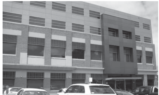
写真1 NDYメルボルン本社の外観
