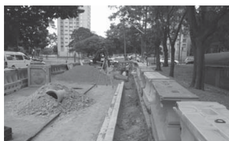
自転車専用道路建設現場
