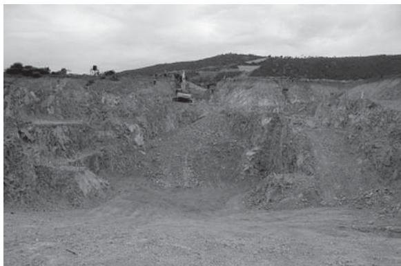
写真1 掘削中の発電所付近
