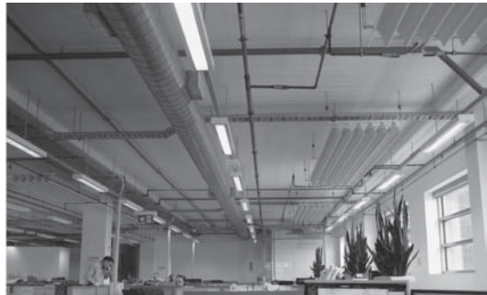
写真2 NDYメルボルン本社の内部見上げ
