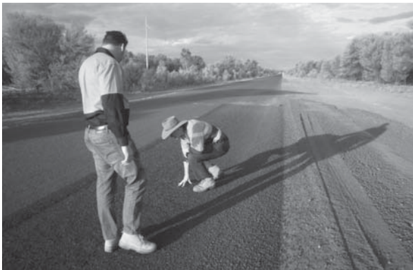
写真2 施工不良がないか、約100kmに渡り点在する施工箇所を回ってチェック
